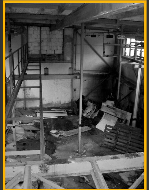
Im September 2009 startet der Ausbau. Die Halle und die einzelnen Räume werden entrümpelt, Rohre und Kabel entfernt, Mauern abgetragen.
